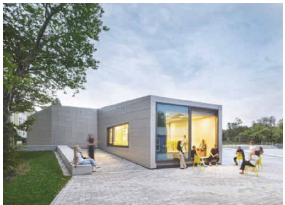
Die aus dem Grundkubus auskragenden Einzelräume bieten großzügige Ausblicke in den Außenraum.
