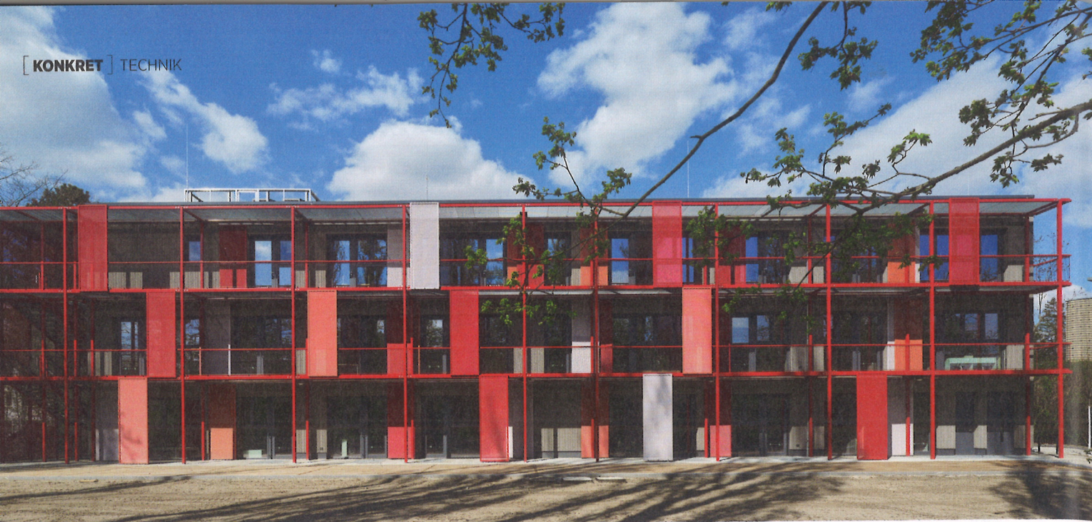
Kita „Typ 150 minus“: Das Architekturbüro karlundp plante eine dreigeschossige Variante in Holzbauweise. Durch eine akribische Stoffauswahl und Einbaukontrolle gelang es, dass die Raumluftmessung bereits zum Zeitpunkt der Fertigstellung stimmt.
