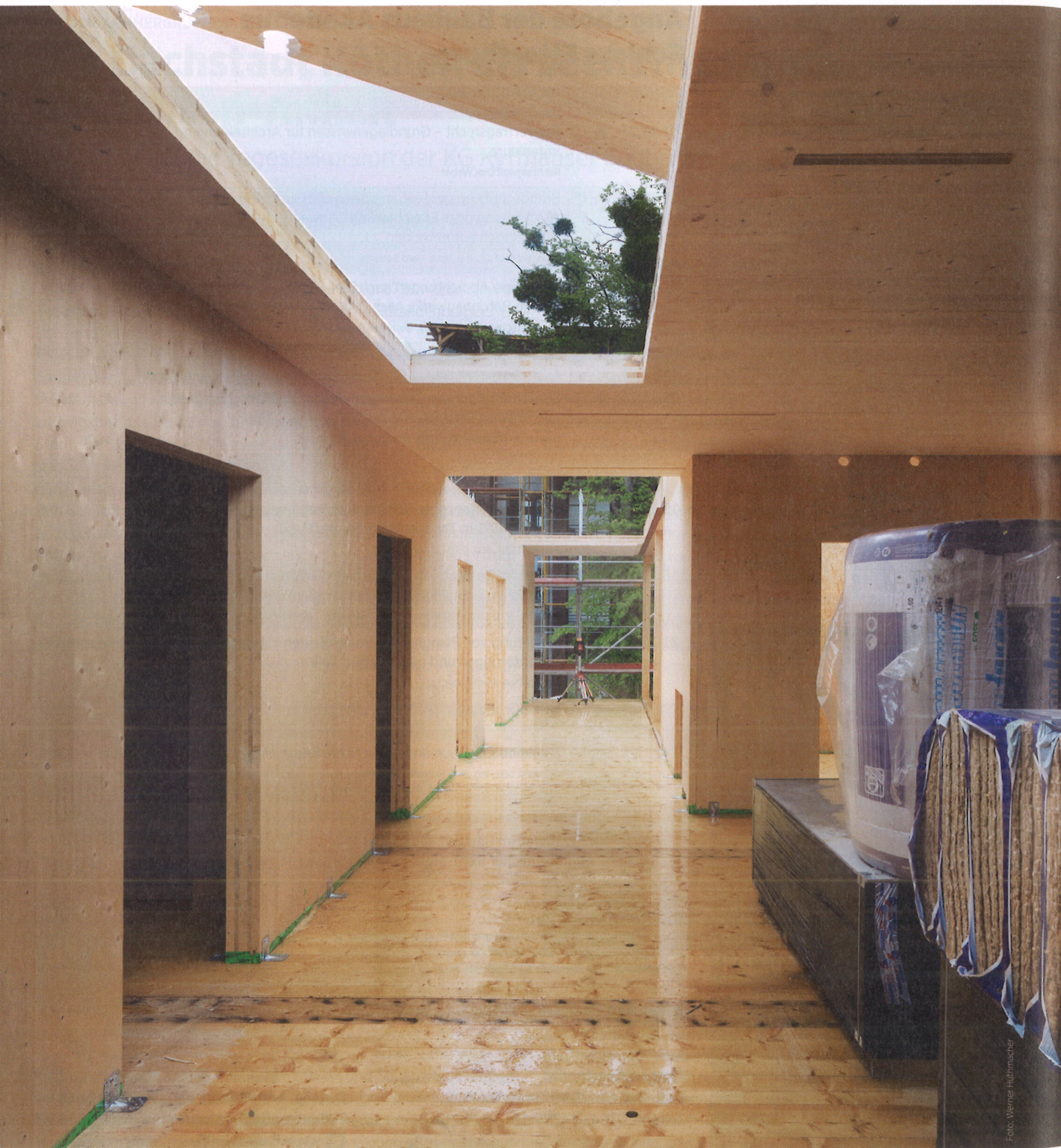
Für die MOKIBs (Modulare Kita-Bauten für Berlin) – hier „Typ 60 plus“ von Kersten Kopp Architekten – wurden schadstoffarme Baustoffe verwendet.
