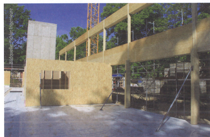
Die Gebäudelängsseiten basieren aufgrund der durchlaufenden, horizontalen Durchfensterung auf einer Holzskelett-/ Pfosten-Riegel-Mischkonstruktion. Zuerst wurde das tragende Skelett aus Brettschichtholzstützen und Trägern errichtet. Dabei laufen die BSH-Stützen vom EG bis zum OG durch.
