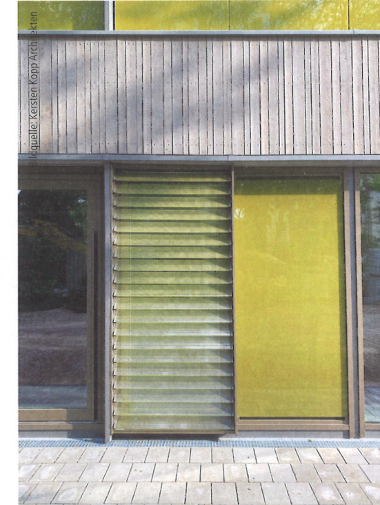
Die Fassadenschalung aus Lärchenholz, die mit den die Fensterzonen gliedernden, 1 cm dünnen und farbig emaillierten Glaspaneelen dezent kontrastiert, sitzt hier auf einer 180 mm tiefen Konterlattung als Hinterlüftungsebene.
