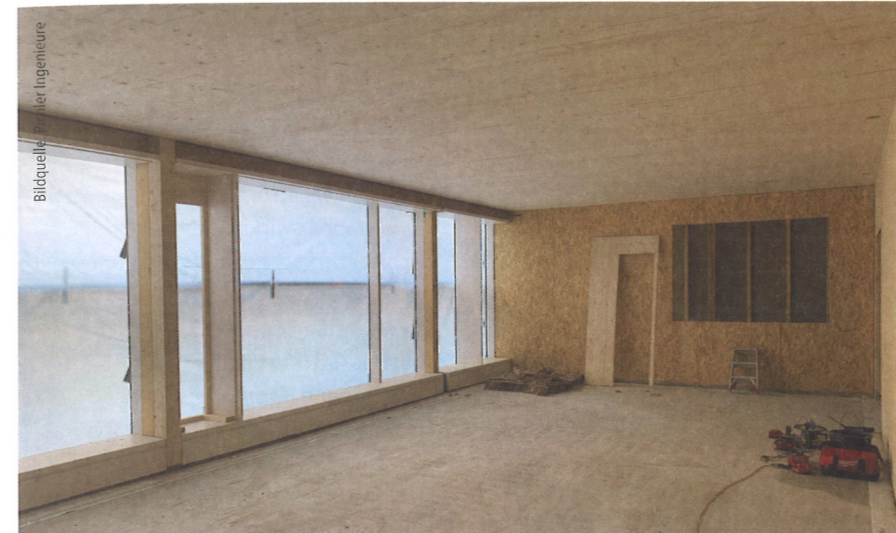
In ausgesuchten Zonen waren die Innenwände und Decken dank geschliffener Oberflächen in Sichtqualität direkt mit dem Einbau fertiggestellt.
