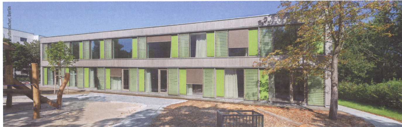
Die Pfosten-Riegel-Konstruktion enthält sowohl die dreifach verglasten Fensterelemente als auch die Fassadenschalung aus Lärchenholz, die auf einer 180 mm tiefen Unterkonstruktion sitzt.
