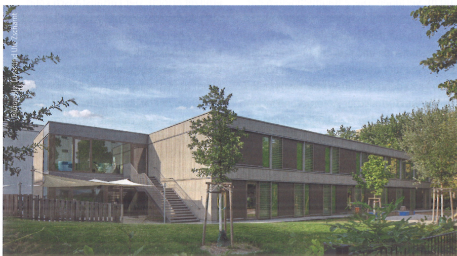
Die stählerne Außentreppe im OG erfüllt gleich zwei Aufgaben: Zum einen dient sie als sicherer Fluchtweg im Brandfall, zum anderen ermöglicht sie den Kindern einen direkten Zugang zum Garten.
