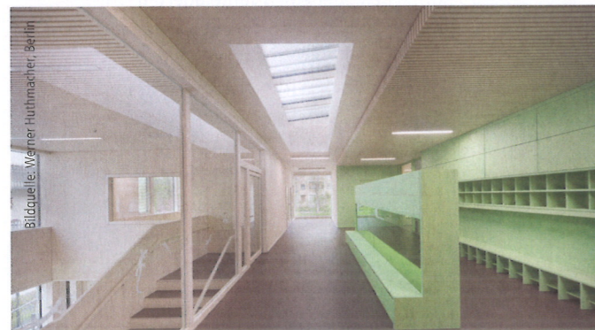
Der durchlaufende Mittelflur im OG wird durch die großzügigen Oberlichter auf natürlichem Wege mit Licht durchflutet.
