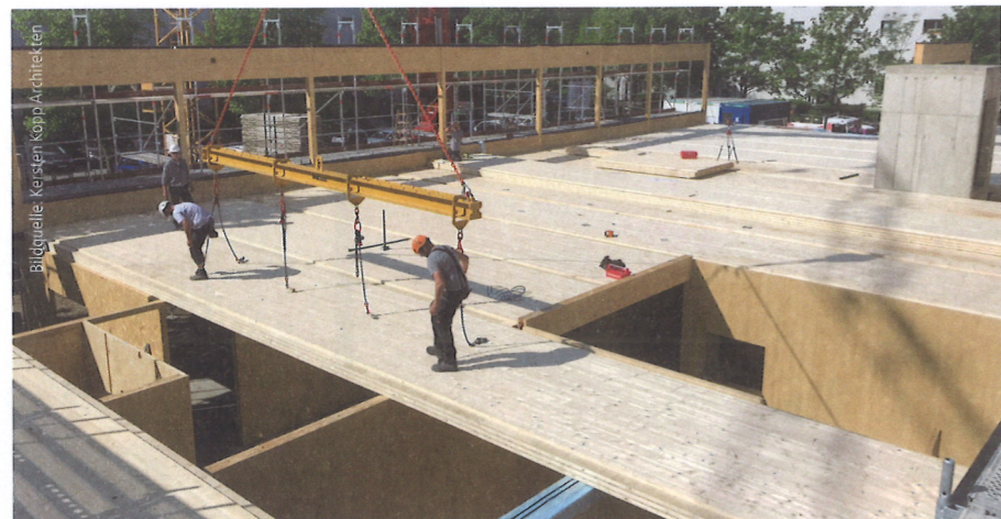
Der Einsatz der werkseitig vorgefertigten, großdimensionalen BSP-Deckenelemente mit den maximalen Abmessungen von 17,87 m x 2,50 m hat den Bauprozess vereinfacht und beschleunigt. Die Elementdicke liegt zwischen 20 und 22 cm.
