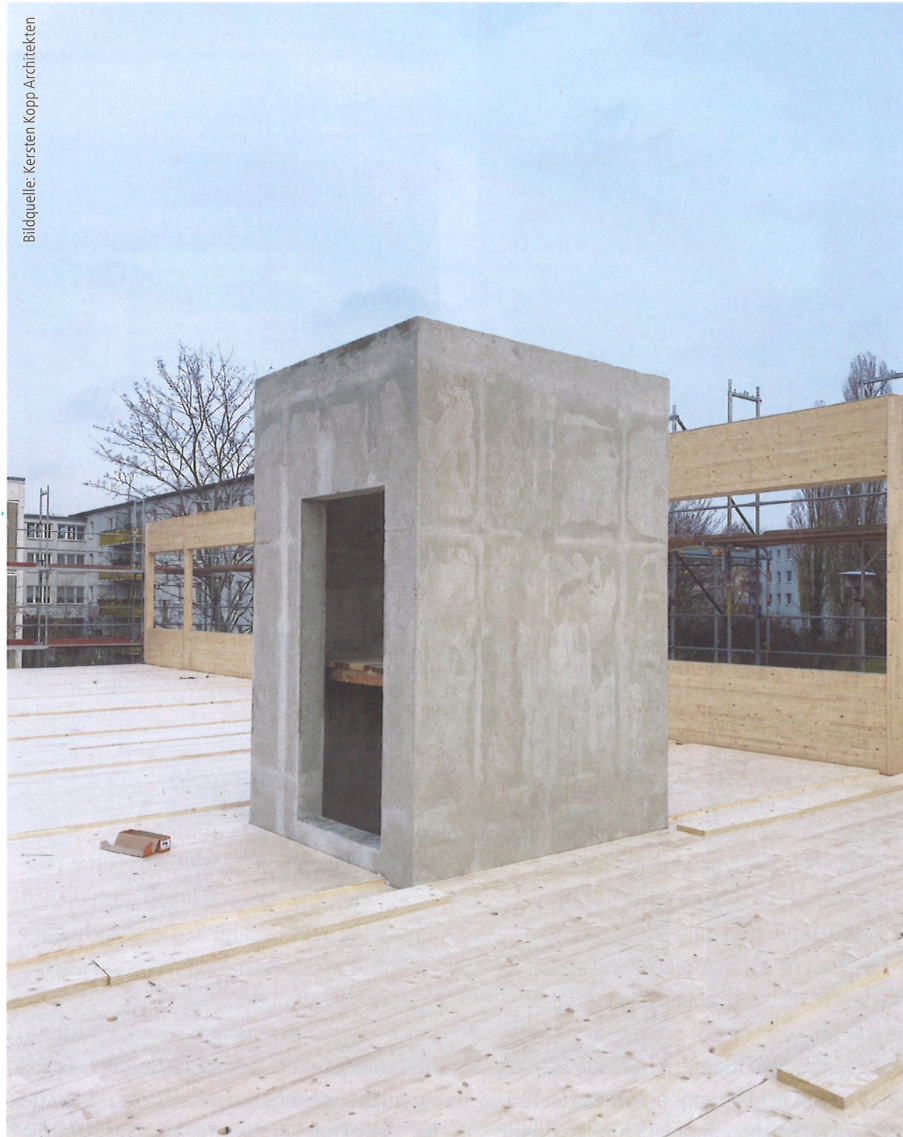
Die barrierefreie Erschließung erfolgt über einen Aufzug in einem Schacht aus 20 cm dicken, nicht brennbaren Stahlbetonfertigelementen.
