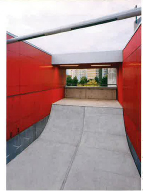
Zwei eingehängte Betonfertigteile bilden die Halfpipe
