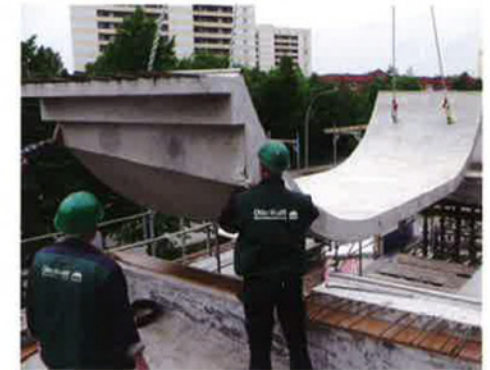
Die Betonfertigteile für die Halfpipe werden eingesetzt
