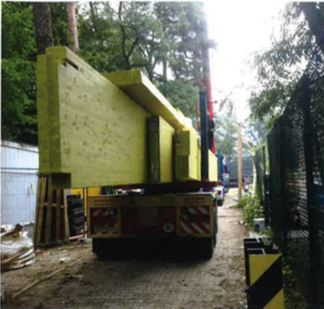
▲ Bindertransport in der Baustellenzufahrt
