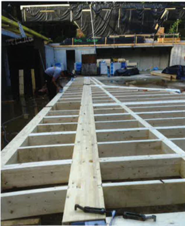
▲ Montage der Ständerwand aus Brettschichtholz
